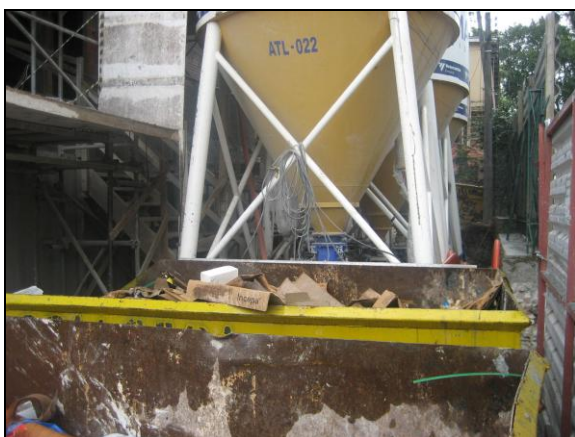
FIGURA 52 – CAÇAMBAS DE RESÍDUOS MISTURADOS (CONSTRUTORA 16). FONTE: Foto da autora.
