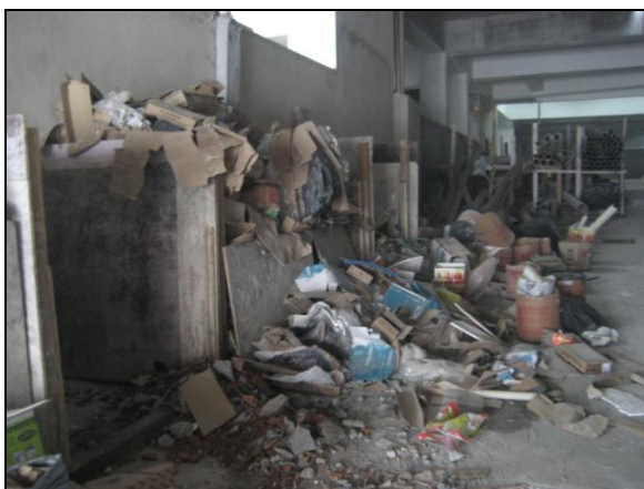
FIGURA 32 – RESÍDUOS MISTURADOS SEM LOCAL ADEQUADO PARA ARMAZENAGEM (CONSTRUTORA 11).
