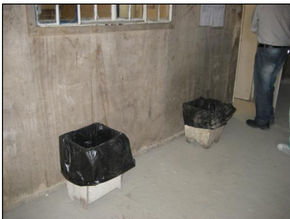
FIGURA 40 – COLETORES SEM IDENTIFICAÇÃO (CONSTRUTORA 13).
