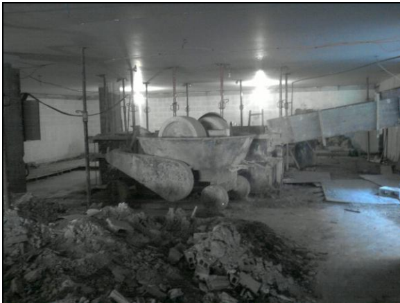
FIGURA 12 – MOINHO DE CALIÇAS (CONSTRUTORA 5). FONTE: Foto da autora.
