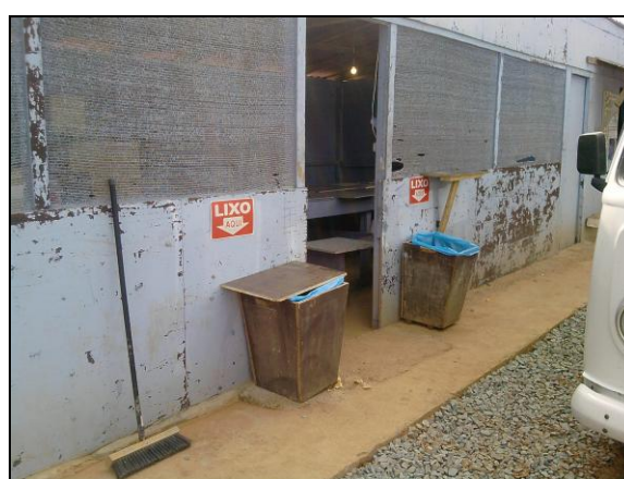
FIGURA 37 – COLETORES COM IDENTIFICAÇÃO ÚNICA PERMITINDO MISTURA DE TIPOS DE RESÍDUOS (CONSTRUTORA 12). FONTE: Foto da autora.
