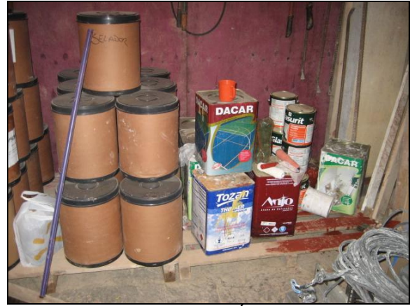
FIGURA 3 – PRODUTOS QUÍMICOS ARMAZENADOS EM CIMA DE PALETES ADEQUADAMENTE E SEPARADAMENTE (CONSTRUTORA 1). FONTE: Foto da autora.
