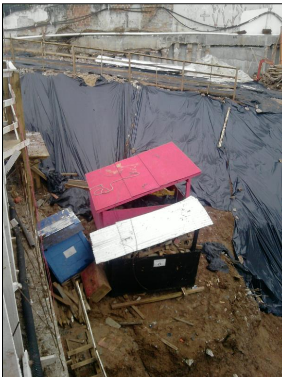
FIGURA 30 – LOCAIS ADEQUADOS PARA RESÍDUOS, COM IDENTIFICAÇÃO (CONSTRUTORA 10).
