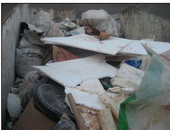
FIGURA 44 – RESÍDUOS DIVERSOS MISTURADOS EM OUTRA CAÇAMBA, PARA POSTERIOR SEPARAÇÃO (CONSTRUTORA 14). FONTE: Foto da autora.
