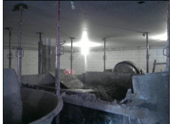
FIGURA 13 – DEPOIS DE TRITURADAS, AS CALIÇAS SÃO MISTURAS À ARGAMASSA, PARA FAZER O CONCRETO (CONSTRUTORA 5). FONTE: Foto da autora.
