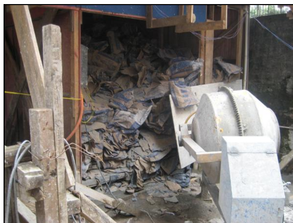
FIGURA 55 – LOCAL SEPARADO PARA RESÍDUOS DE PAPELÃO, APENAS SEM IDENTIFICAÇÃO (CONSTRUTORA 17). FONTE: Foto da autora.
