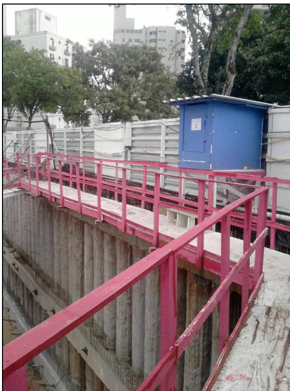
FIGURA 31 – LOCAL ADEQUADO PARA RESÍDUOS DE “PAPEL BRANCO” (CONSTRUTORA 10).
