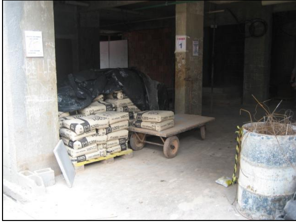
FIGURA 2 – LOCAL LIMPO, ORGANIZADO E COM IDENTIFICAÇÃO DE LOCAL PARA SEGREGAÇÃO (CONSTRUTORA 1). FONTE: Foto da autora.
