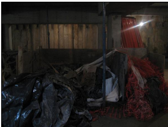
FIGURA 54 – LOCAIS SEPARADOS PARA RESÍDUOS E MATERIAIS, APENAS SEM IDENTIFICAÇÃO (CONSTRUTORA 17). FONTE: Foto da autora.
