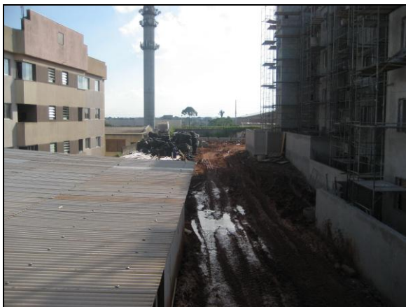
FIGURA 42 – MATERIAL SEPARADO PARA UTILIZAÇÃO (CONSTRUTORA 14). FONTE: Foto da autora.
