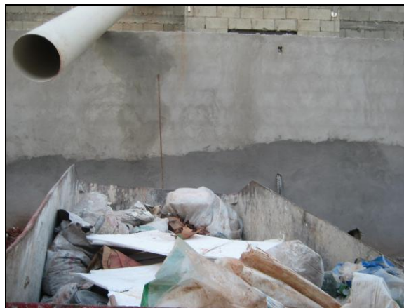
FIGURA 43 – RESÍDUOS MISTURADOS PARA POSTERIOR SEPARAÇÃO (CONSTRUTORA 14). FONTE: Foto da autora.
