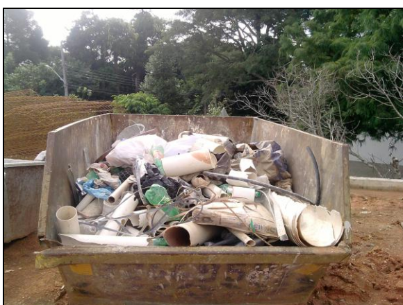
FIGURA 36 – RESÍDUOS MISTURADOS EM UMA CAÇAMBA PARA POSTERIOR SEPARAÇÃO POR EMPRESA TERCEIRIZADA (CONSTRUTORA 12). FONTE: Foto da autora.
