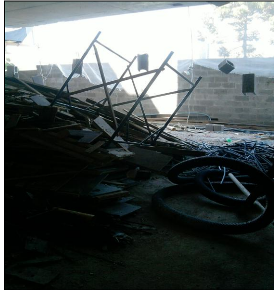
FIGURA 9 – ARMAZENAGEM DE MADEIRA COM OUTROS RESÍDUOS DA OBRA (CONSTRUTORA 4). FONTE: Foto da autora.
