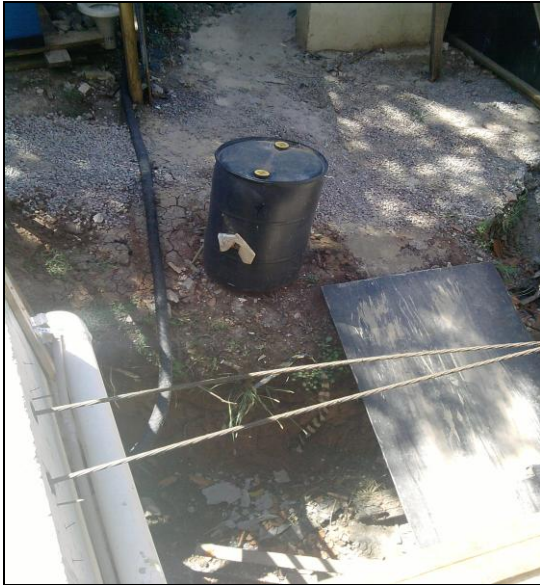
FIGURA 8 – DETALHE DO TAMBOR DE ÓLEO INADEQUADAMENTE ARMAZENADO (CONSTRUTORA 4). FONTE: Foto da autora.
