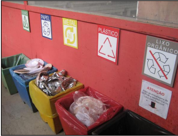
FIGURA 14 – COLETORES EM ILHAS DE COLETA, IDENTIFICADOS POR TIPO DE RESÍDUO (CONSTRUTORA 6).
