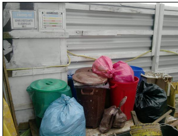
FIGURA 29 – PLACAS ORIENTADORES E PLÁSTICOS COLORIDOS PARA IDENTIFICAR OS TIPOS DE RESÍDUOS (CONSTRUTORA 10).
