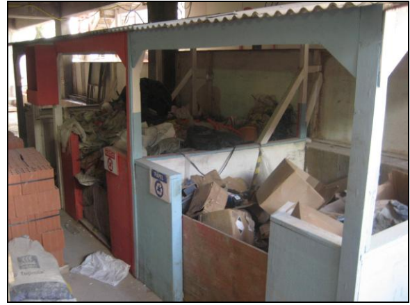
FIGURA 15 – ÁREAS IDENTIFICADAS PARA SEGREGAÇÃO DE RESÍDUOS (CONSTRUTORA 6).
