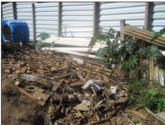
FIGURA 46 – MATERIAIS PARA UTILIZAÇÃO, MISTURADO COM RESÍDUOS (CONSTRUTORA 15). FONTE: Foto da autora.
