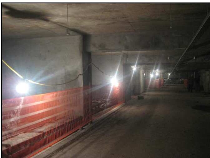
FIGURA 18 – ORGANIZAÇÃO DOS MATERIAIS PARA UTILIZAÇÃO NA OBRA (CONSTRUTORA 6). FONTE: Foto da autora.
