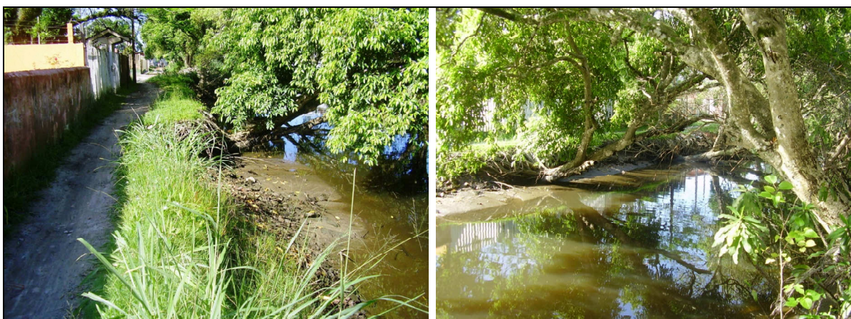
FIGURA 4.3 - Processos erosivos à margem do Rio Guarituba
