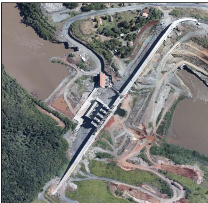
FIGURA 7 - USINA HIDRELÉTRICA MAUÁ
