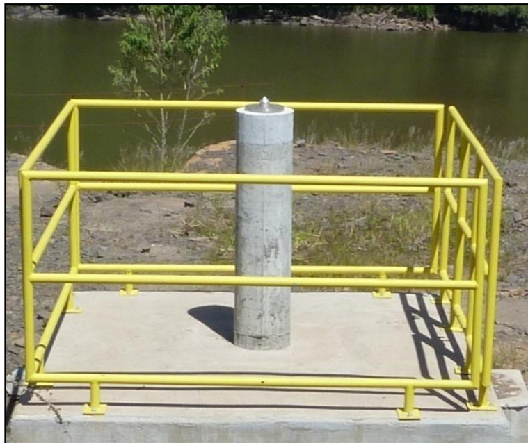
FIGURA 17 – PILAR GEODÉSICO PG03 E GRADES DE PROTEÇÃO
