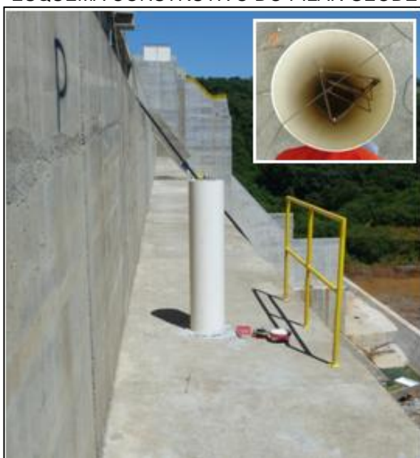
FIGURA 15 - ESQUEMA CONSTRUTIVO DO PILAR GEODÉSICO PGG01
