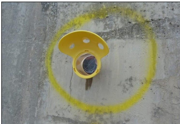
FIGURA 27 - PRISMA GPR112 NO MURO DA BARRAGEM
