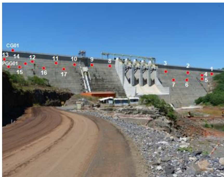
FIGURA 32 - DISPOSIÇÃO APROXIMADA DOS ALVOS IMPLANTADOS A JUSANTE DA BARRAGEM
