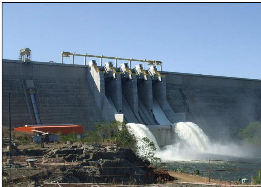
FIGURA 2 - COMPORTAS DA USINA HIDRELÉTRICA MAUÁ
