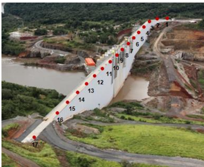
FIGURA 34 - DISPOSIÇÃO APROXIMADA DOS ALVOS IMPLANTADOS A MONTANTE DA BARRAGEM
