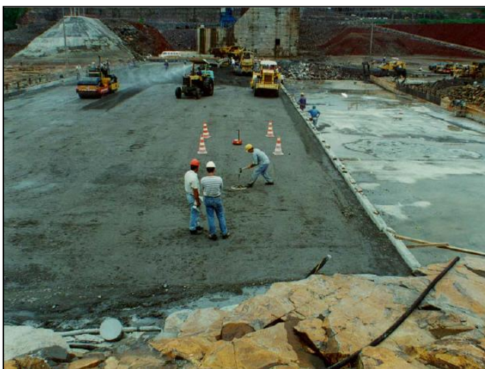
FIGURA 1 – VISTA GERAL DA PRAÇA DE CCR DA UHE DE SALTO CAXIAS
