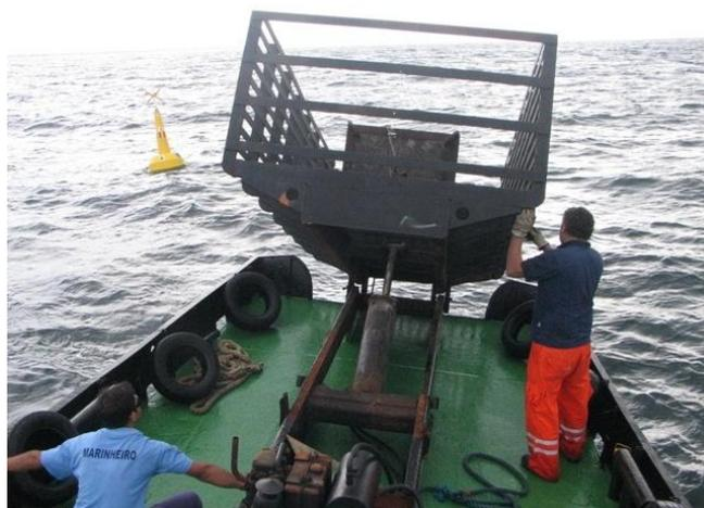
FIGURA 30 - Instalação no ponto 10 (Pontal do Paraná) da boia oficial do Projeto REBIMAR e do sistema de amarração: cabos de aço e poita de concreto a partir do rebocador Genesis I (junho de 2010)
