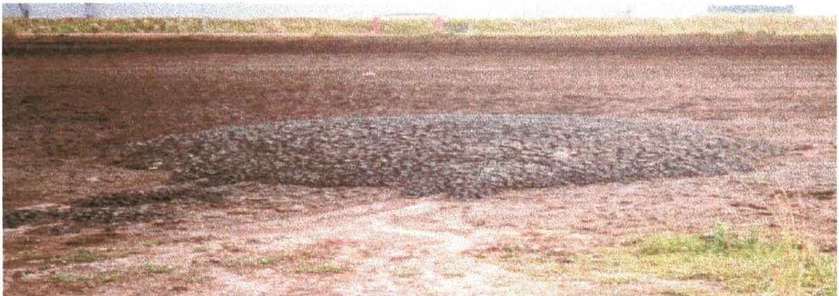
Figura 2: “Aplicação de Lodo de Esgoto na Entrada das Células”
