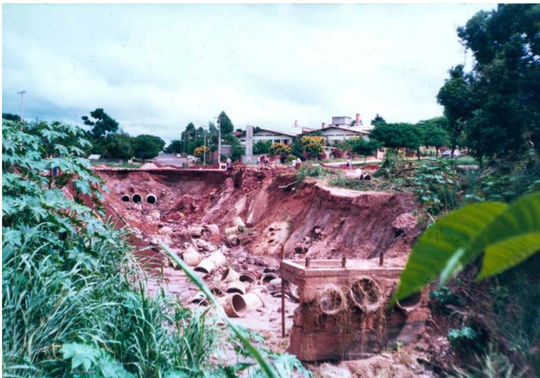
NOTA: Danos Provocados por voçoroca no sistema de drenagem pluvial da cidade de Umuarama - PR, anos 80.
