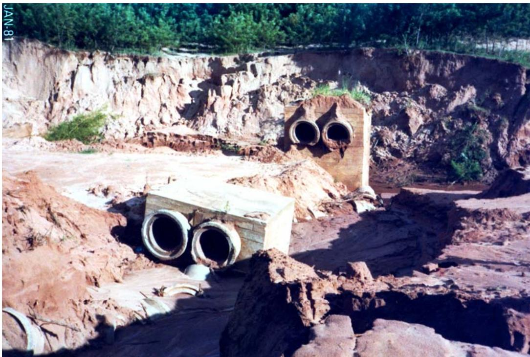
NOTA: Danos provocados por voçoroca no sistema de drenagem pluvial da cidade de Douradina-PR, 1981.
