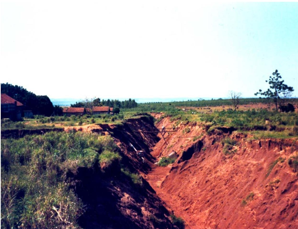
NOTA: Erosão perto de conjunto residencial em Douradina-PR, anos 1980. No detalhe, poste com transformador danificados e ponte utilizada pelos moradores para transpor a voçoroca.
