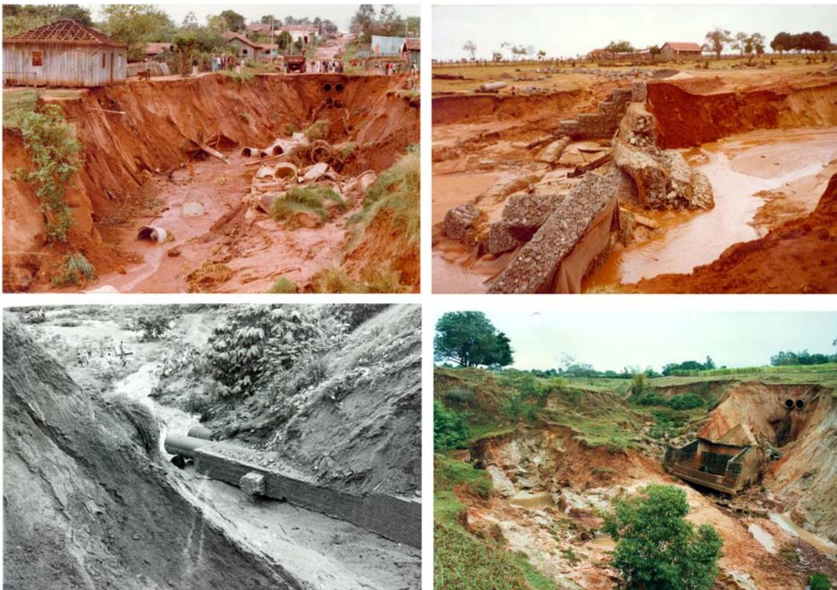
FOTO 01 - ICARAÍMA-PR, EROSÃO EM ATIVIDADE DE DESTRUIÇÃO DA GALERIA PLUVIAL, ANOS 70
