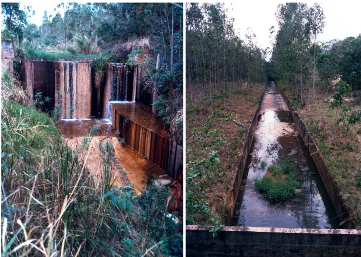
NOTA: Foto 01 - Obra para dissipação da energia da água e Foto 02 - Aspecto do plantio de *Grevillea robusta* no entorno do canal de drenagem de concreto.
