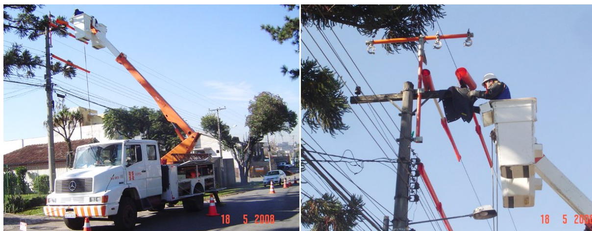
Figura 2.1: Manutenção em linha viva.
