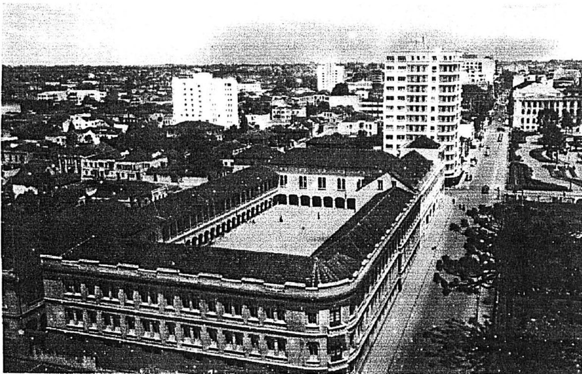
Vista aérea do Colégio Santa Maria, na década de 1950. Acervo: Colégio Santa Maria
