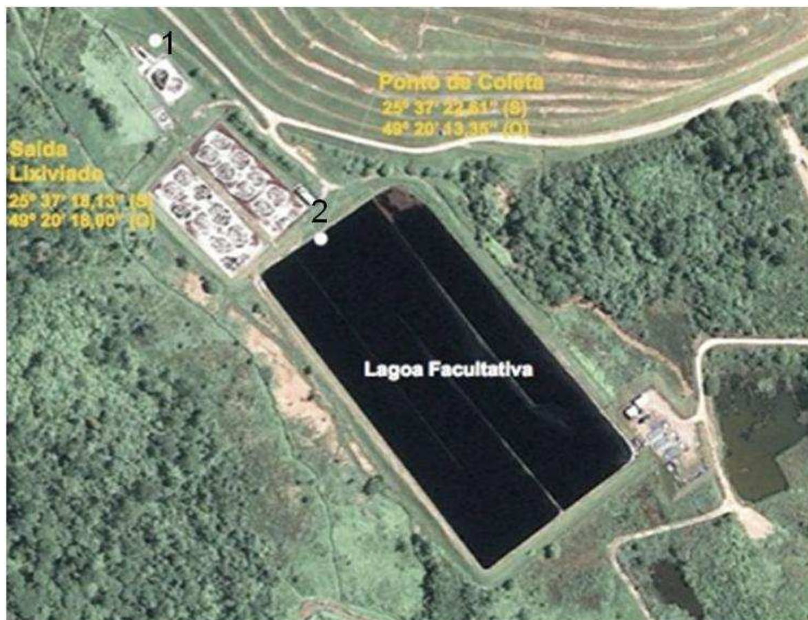
FIGURA 3.1 - VISTA AÉREA DO ATERRO SANITÁRIO DE CURITIBA (25°,37' 15,35"S; 49°,20' 18,82"O): (1) EMISSÁRIO CENTRAL E (2) LAGOA FACULTATIVA
