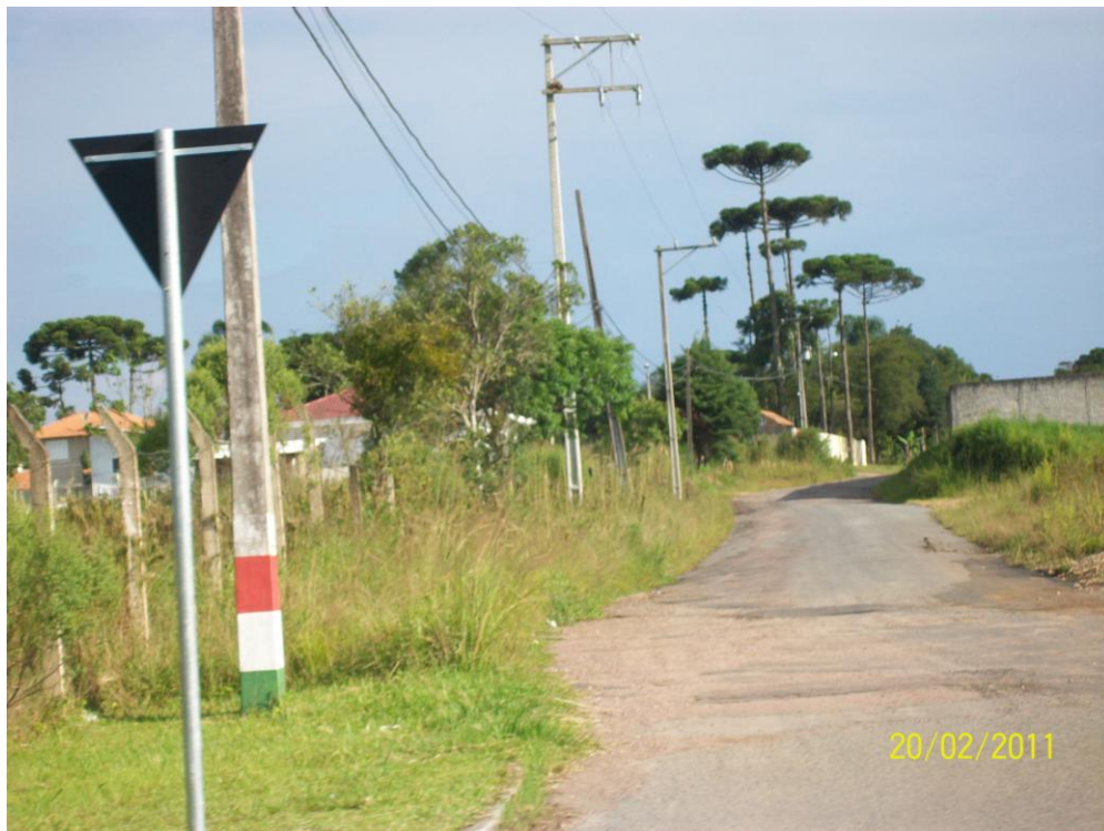
FOTO 9: Parte do Caminho do Vinho com asfalto.
