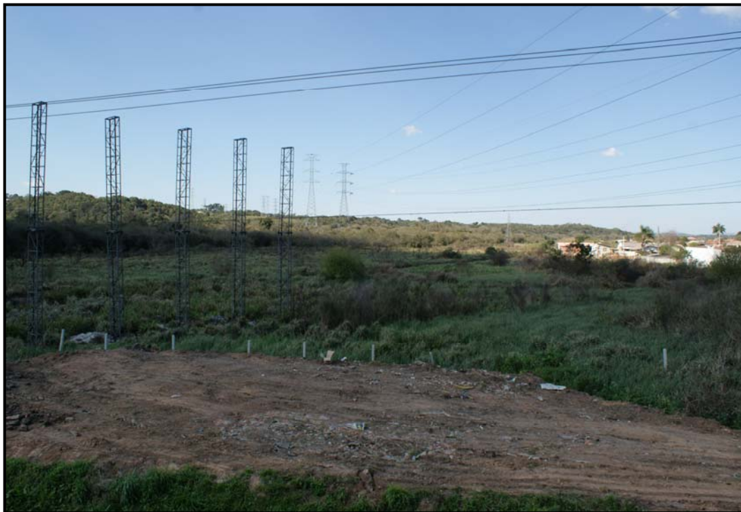
FIGURA 41: Aterro sobre área sujeita à inundaç o do rio Miringuava, nas proximidades do Jardim S o Marcos.
