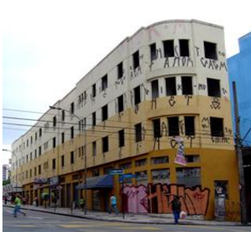
Figura 509 – Prédio desocupado . R. Cruz Machado, próx. à Praça Tiradentes, Centro. Curitiba, 21 dez. 2005. KARRANCA, HELLO e outros. Fonte: Acervo E.S.Prosser.
