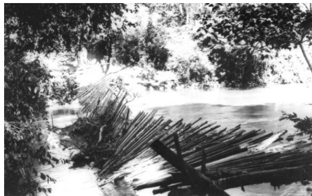
81 - Ponte improvisada sobre o rio Itararé, 1930
