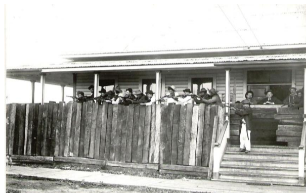
50 - Barreira de proteção ao escritório da Lumber, 1914
