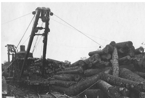
21 - Empilhamento de toras, 1913-1920
