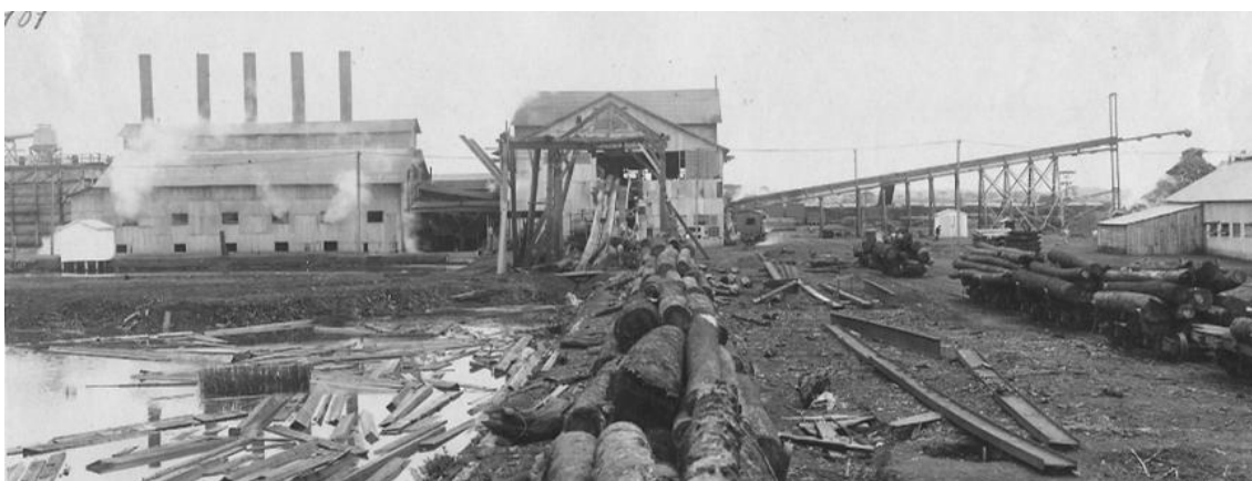
Figura 39 – Esteira sem fim para a condução de toras ao interior da serraria, 1913-1920. Fonte: Acervo da família de Claro Jansson – Itararé, imagem digitalizada por Rubens Habitzreuter
