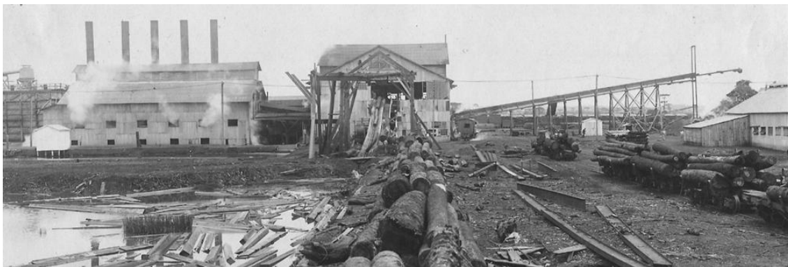
30 - Esteira sem fim para a condução de toras ao interior da serraria, 1913-1920
