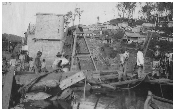
24 - Construção da ponte sobre o rio Uruguai, 1910
