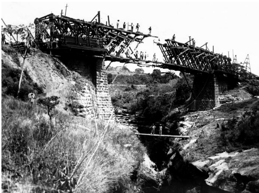
Figura 70 - Construção da ponte provisória sobre o rio Itararé, 1930-1934. Fonte: Acervo da família de Claro Jansson – Itararé, imagem digitalizada por Jandira Jansson
