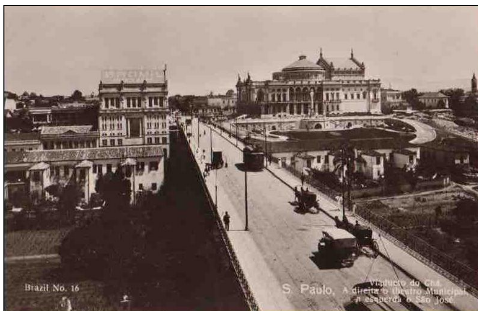
FIGURA 158 - PARA: LILLY LEITE. "VIADUCTO DO CHÁ/ SÃO PAULO, 13-04-1914.
