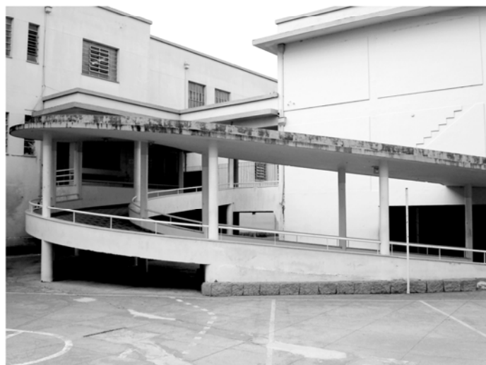
Foto 98: Detalhe da rampa do Colégio Estadual Pietro Martinez, em Curitiba - 2008
