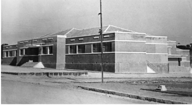
Foto 51: 2ª sede do Grupo Escolar Jesuíno Marcondes, em Palmeira - sem data
