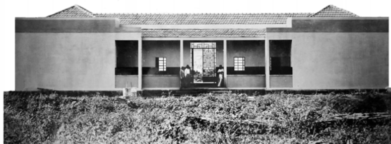
Foto 46: Grupo Escolar de Sertãoópolis - sem data Fachada posterior
