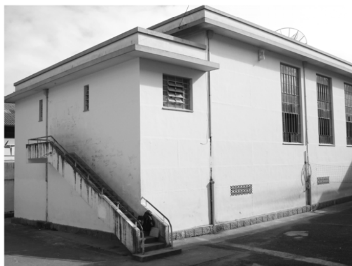
Foto 97: Vista do Bloco posterior do Colégio Estadual Pietro Martinez, em Curitiba - 2008
