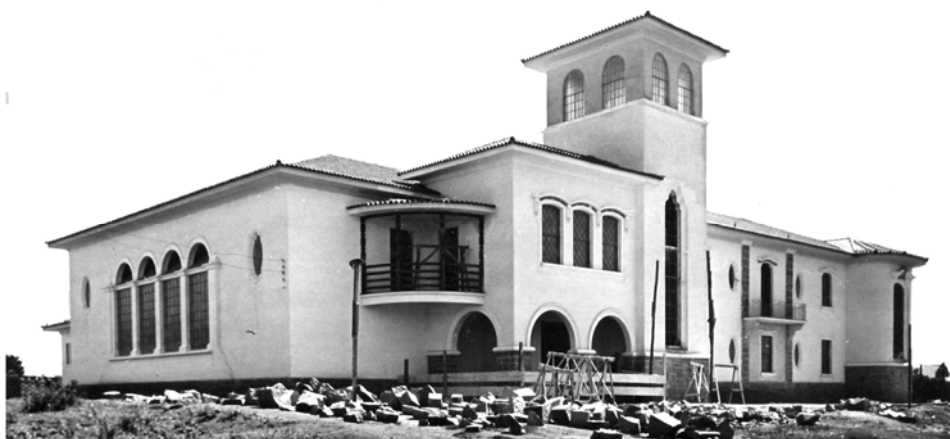
Foto 65: Grupo Escolar Lysimaco Ferreira da Costa, em construção, Curitiba - sem data
