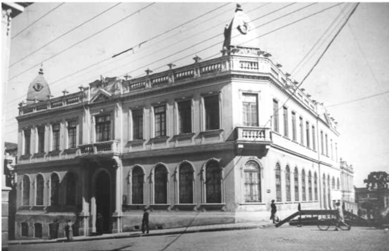
Foto 39: Coletoria, Junta Comercial e Diretoria de Águas e Esgotos de Curitiba - 1942
