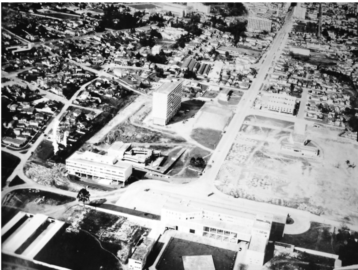
Foto 89: Vista aérea do Centro Cívico de Curitiba em construção - década de 1950
