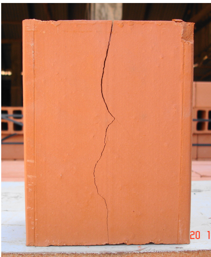
FOTO 5: RACHADURA EM TIJOLO DEVIDO A AUSÊNCIA DE PREPARAÇÃO DA MASSA FONTE: BONATO, 2010.
