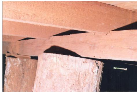
**Figura 06 – DETALHE DO SISTEMA DE ENCAIXE NA FUNDAÇÃO DA CONSTRUÇÃO EM MADEIRA.**
