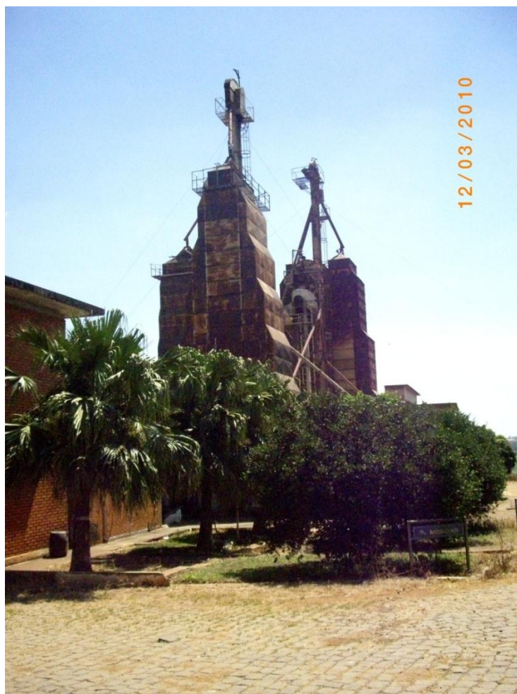
Figura 2.2- Secador Tipo Fluxo Misto em Torre.
