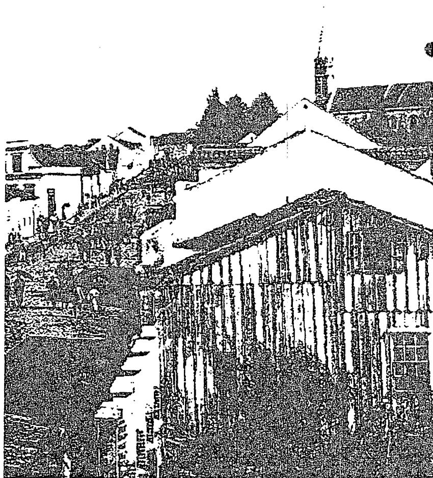
Fig.21 -No primeiro plano, a fachada de alvenaria esconde o péssimo estado da paredes externas de madeira. Foto do início do século. Acervo: Casa da Memória.
