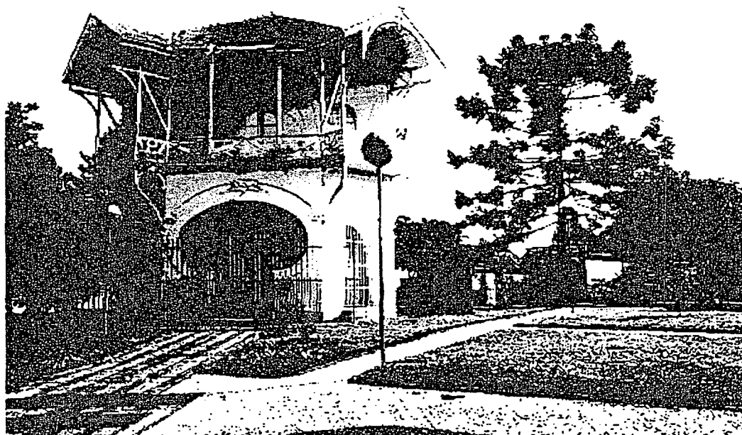
Fig.25 -Belvedere da Praça João Cândido, projeto de Cândido de Abreu, considerado como um dos mais genuínos exemplares art-nouveau de Curitiba. Acervo: Casa da Memória.
