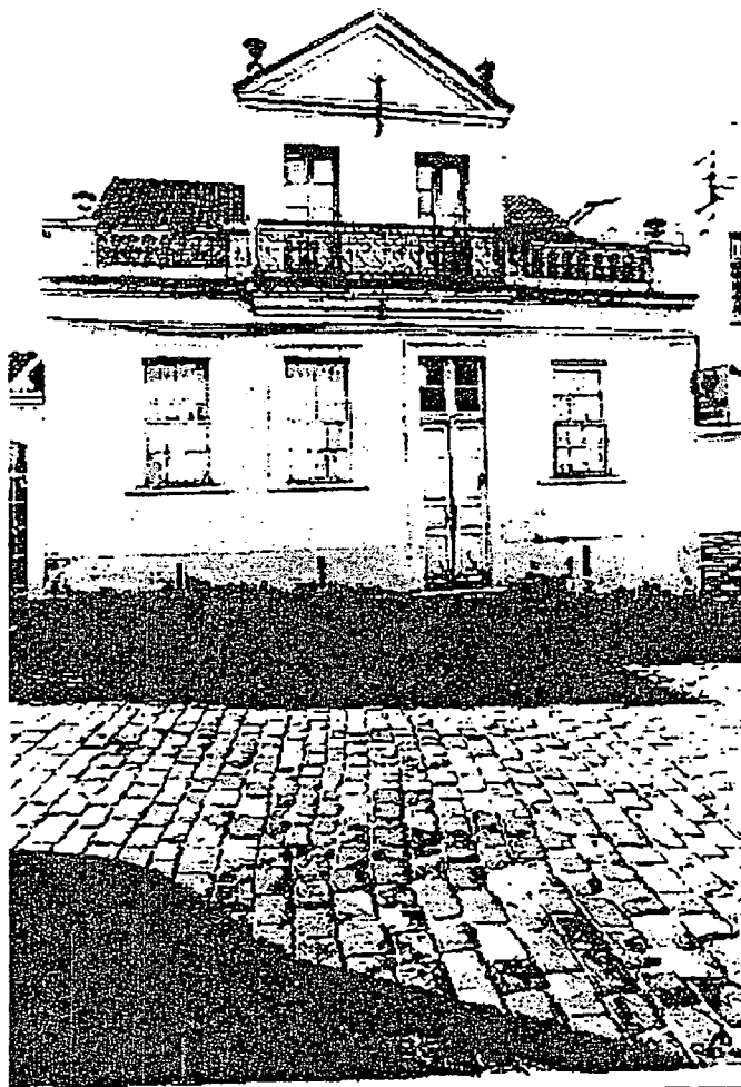
Fig.11 -Encontrado em muitas construções de influência alemã, o corpo menor e centralizado, sobressaindo-se, seria uma maneira de aproveitamento do sótão. Acervo: Casa da Memória.
