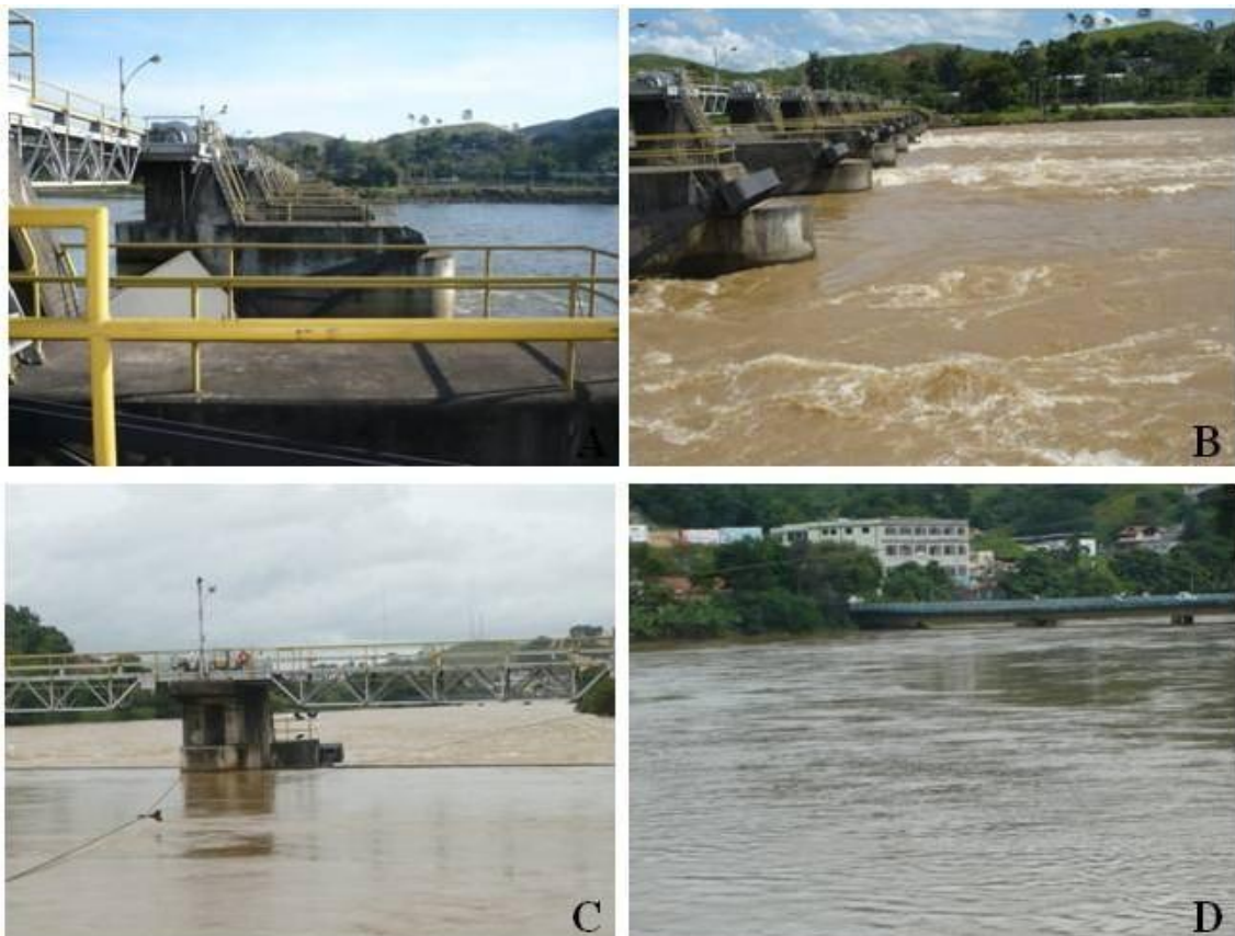
FIGURA 17. A. Vista da barragem da UHE Santa Cecília em Junho/2008 (1ª coleta). B - Vista da barragem da UHE Santa Cecília em Fevereiro/2009 (2ª coleta). C - Vazão elevada em Santa Cecília obrigando a abertura das comportas para evitar enchentes à montante da UHE. D - Vazão do rio Paraíba dos Sul, notavelmente com a altura muito próxima à ponte.
