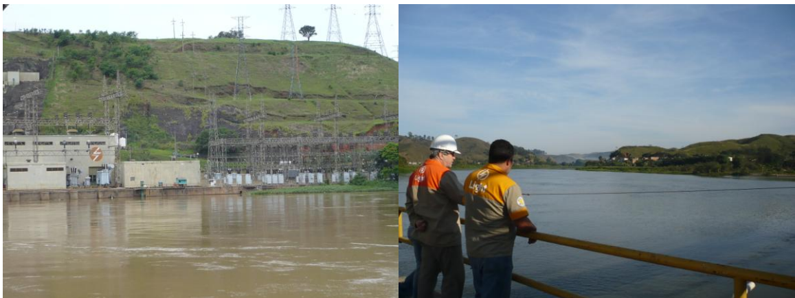
FIGURA 8. Reservatório da UHE Santa Cecília/RJ
