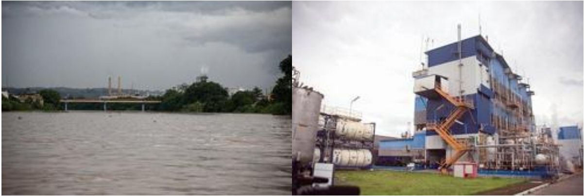
FIGURA 10. Empresa Servatis instalada no rio Paraíba do Sul, responsável pelo acidente em novembro/2008 com o derramamento de 8.000 litros do pesticida Endosulfan .
