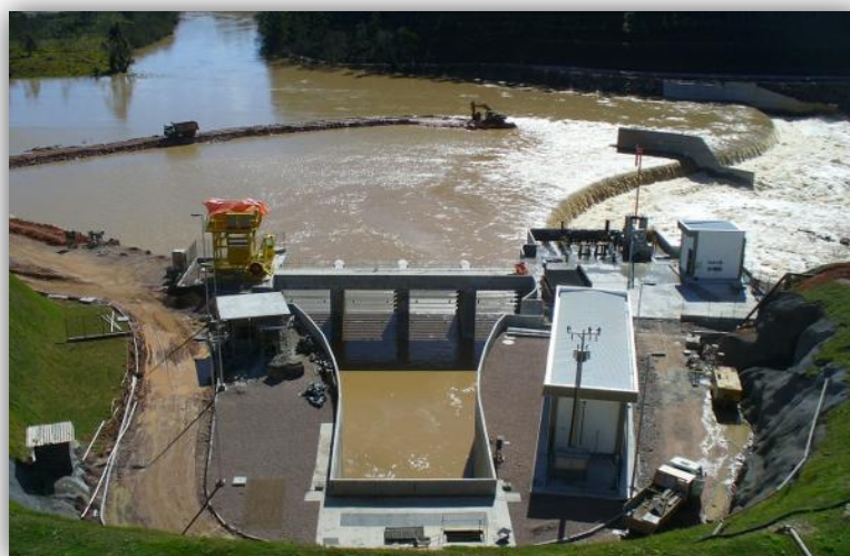
FIGURA 10 – Barragem UHE-Salto Pilão, acesso do túnel de captação de água para as turbinas.
