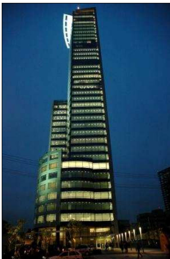
Figura 2.2 – Edifício E-Tower, São Paulo (fonte: foto cedida pela Eng a Carine Hartmann)
