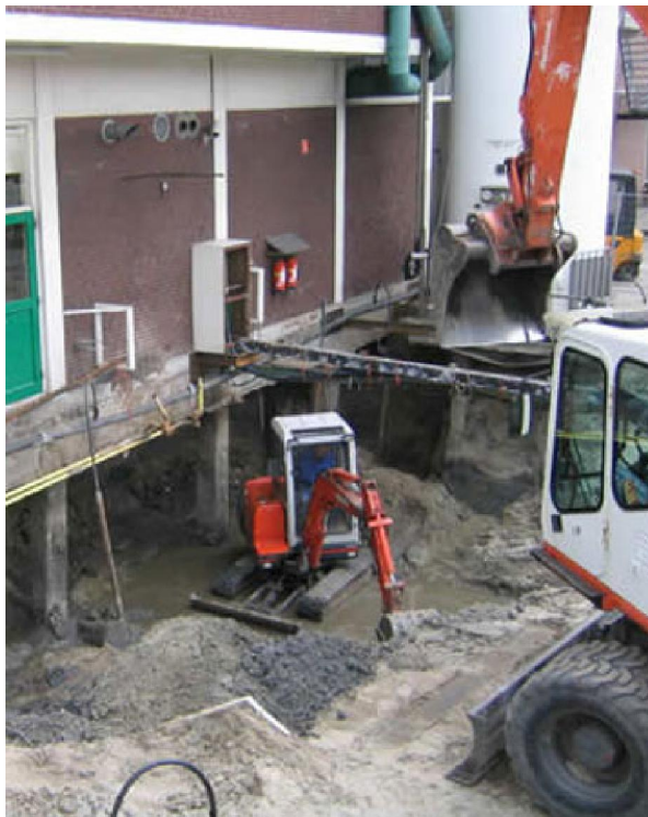
FIGURA 1 – RETIRADA DE SOLO CONTAMINADO PARA REMEDIAÇÃO (KWA, 07/10/2008)
