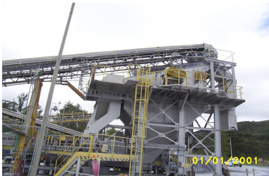
FIGURA 8 - DETALHE DA PENEIRA VIBRATÓRIA MNS-60024. FONTE: Votorantim.
