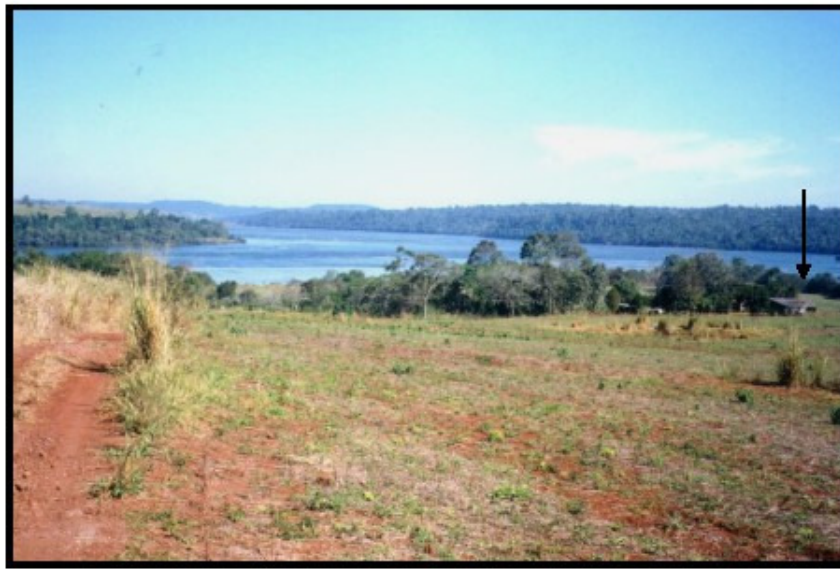
Figura 6. Estação 5: vista geral da foz do rio Gonçalves Dias com o rio Iguazu.
