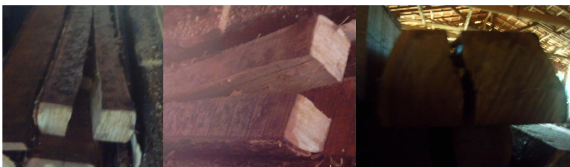
FIGURA 9 – RACHADURAS DESENVOLVIDAS DURANTE O PROCESSO DE DESDOBRO
