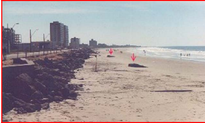
FIGURA 31 - Praia de Caiobá em 1983. Notar setas vermelhas (gabiões já soterrados), tentativa de recuperação da faixa de areia (Foto disponível em: http://www.netpar.com.br/lindroth/bravapor.htm ).
