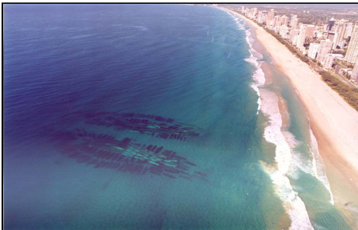
FIGURA 3 - Estrutura submersa na praia de Narrowneck, Austrália. Sacos preenchidos com sedimento de mesma granulometria da praia (BLACK e MEAD 2001).
