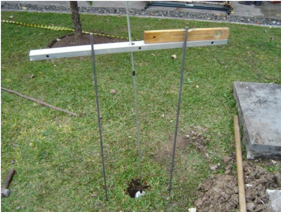
FIGURA 12: DETALHE DO EQUIPAMENTO MONTADO PARA A MEDIÇÃO DO REBAIXO D'ÁGUA COM A UTILIZAÇÃO DA HASTE COM A BÓIA NOTA: Realizado em 05/2006
