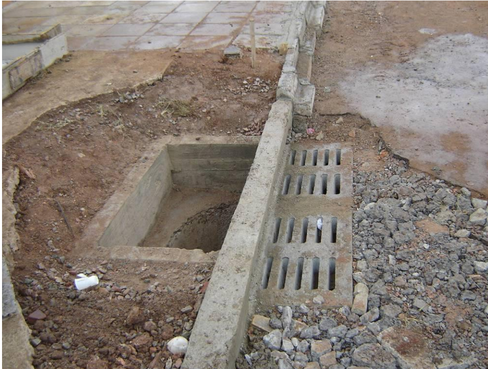
FIGURA 22 - PROTÓTIPO IMPLANTADO NA RUA PRES. WILSON NOTA: Realizada em 08/2006
