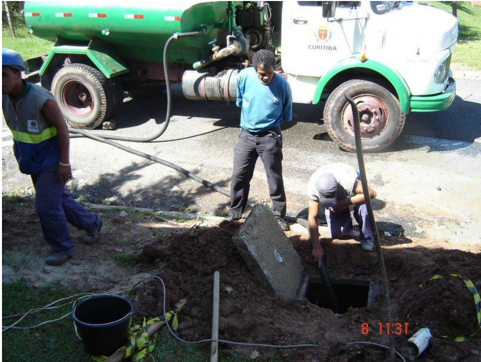
FIGURA 28 – ENCHIMENTO DO SRI COM ÁGUA DO CAMINHÃO PIPA NOTA: Realizada em 03/2007
