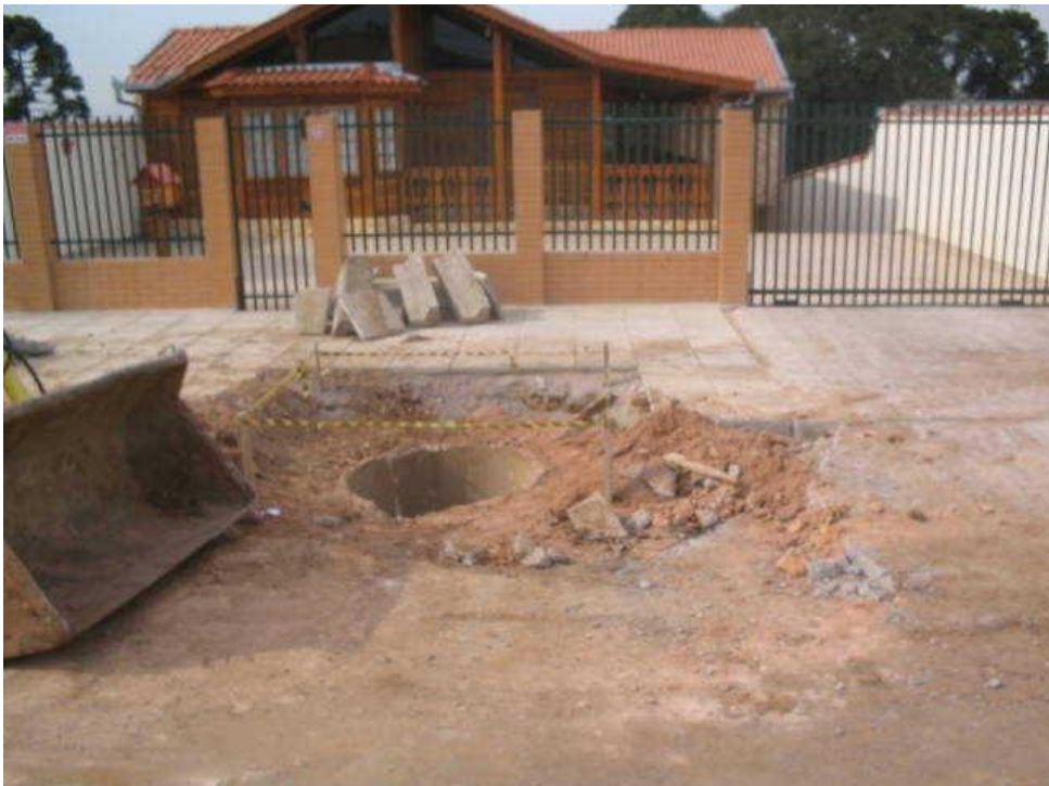
FIGURA 21 - PROTÓTIPO IMPLANTADO NA RUA PRES. WILSON Realizada em 08/2006
