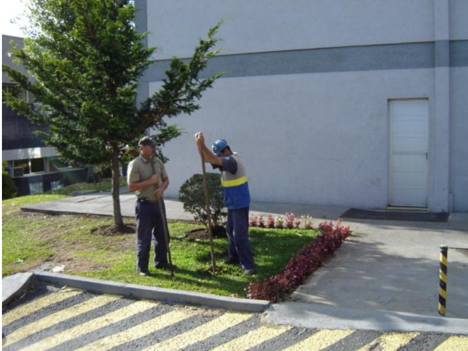
FIGURA 9 - ESCAVAÇÃO DE COVA CILÍNDRICA A TRADO NOTA: Realizado em 05/2006
