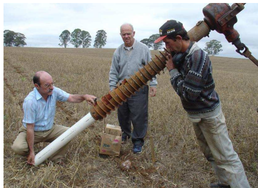
COLOCAÇÃO DO TUBO
