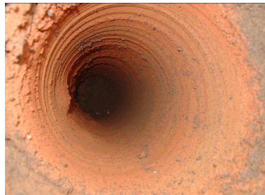
VISTA DO INTERIOR
