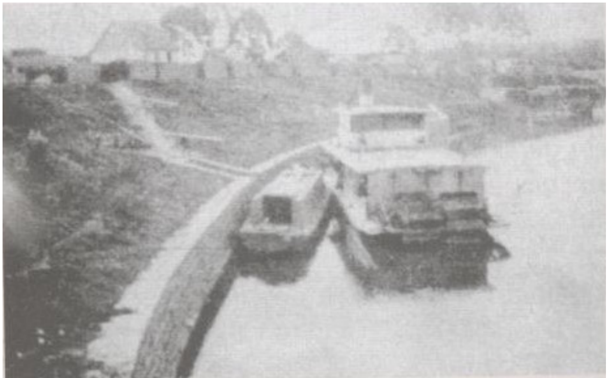
Figura 5 - Cais do Porto Amazonas.
